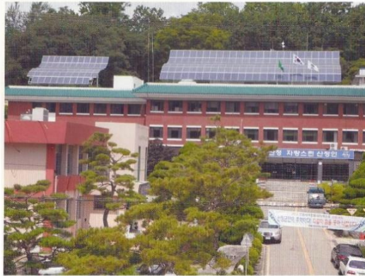
▲ (주)은성파워텍이 신원군청에 설치한 태양광발전 설치 모습.
